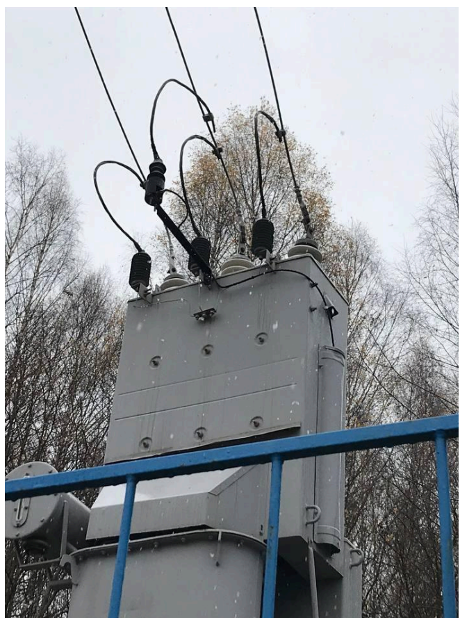
Рис. 4. Фото подключения модема из эксплуатации: слева - модем установлен в шкаф, справа - подключение ёмкостного устройства присоединения на фазу ЛЭП.
